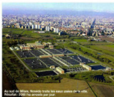
Au sud de Milan, Nosedo traite les eaux usées de la ville. Résultat: 5000 ha arrosées par jour.
